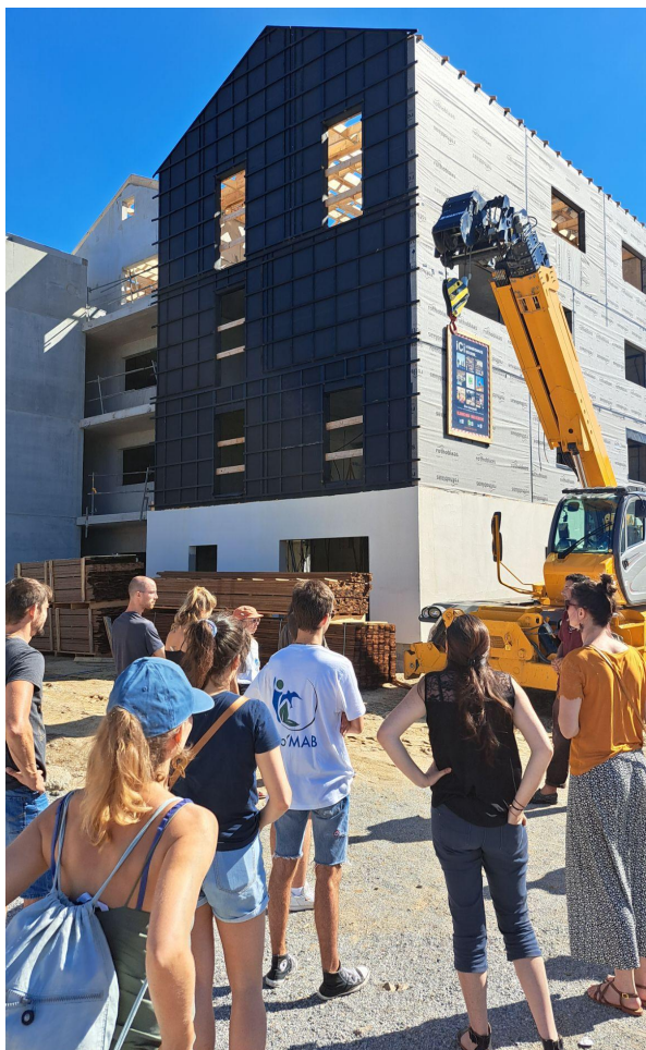
Collectif Terre Crue Presqu'île, écoquartier Maisonneuve, Guérande
